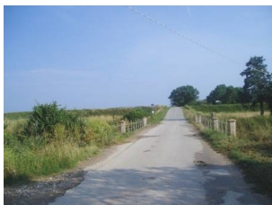
Ponte sul canale seccatore
