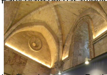
Interno piano terra - Particolare del soffitto con volta crociata.
