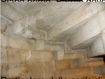
Particolare della scala di collegamento fra i due piani.
