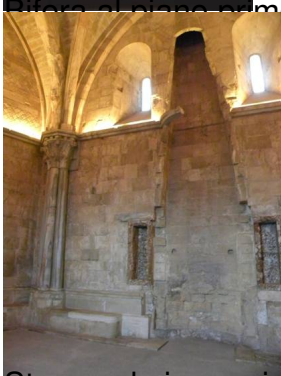
Stanza al piano primo. Impronta del camino sulla parete.
